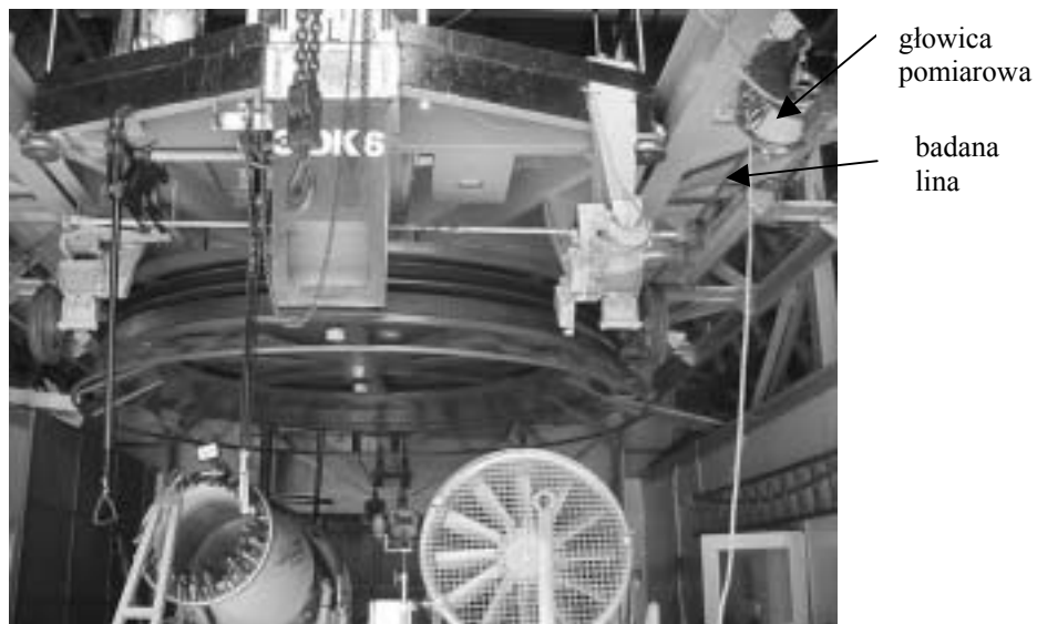
Rys. 3. Badanie magnetyczne liny nośno – napędowej kolei linowej.
