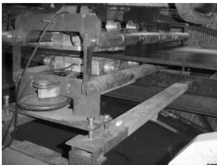
Rys.2. Badanie linek stalowych przenośnika taśmowego (głowica GP9)
