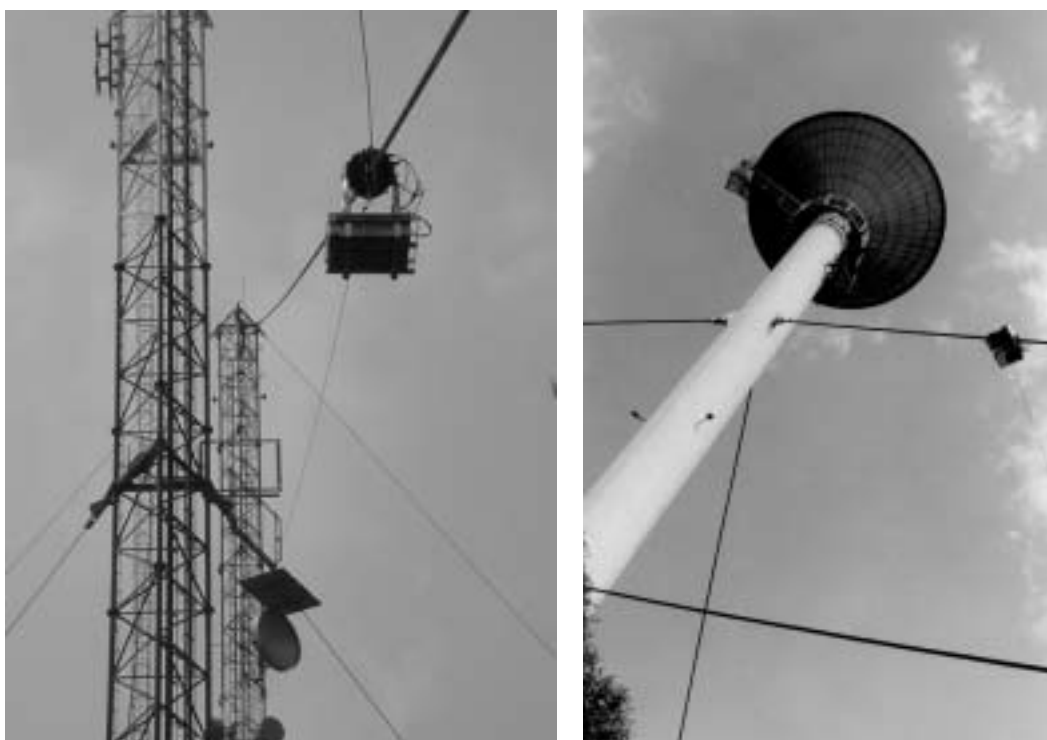
Rys.4. Badanie odcinków linowych masztu telewizyjnego i wieży ciśnień.
