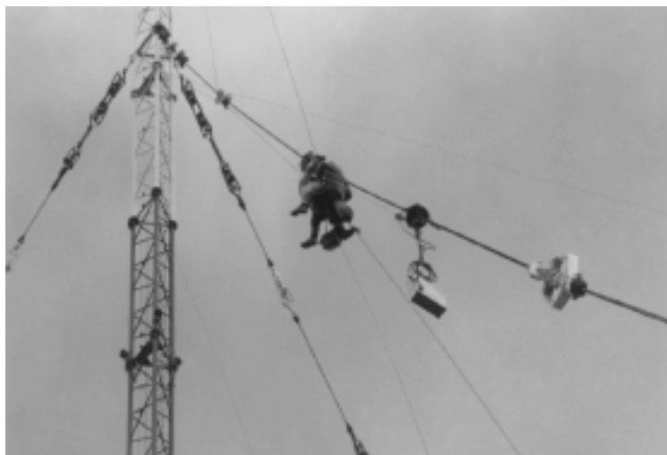
Rys.5. Badania magnetyczne masztu z izolatorami (głowica GM60Split).
