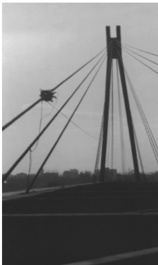
Rys.6. Badanie magnetyczne lin stalowych mostu wiszącego (głowica GM60).
